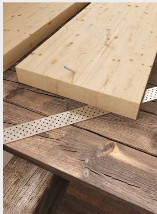
^ Restablecimiento de forjado de madera existente mediante vigas laminadas y conectores VGZ.
